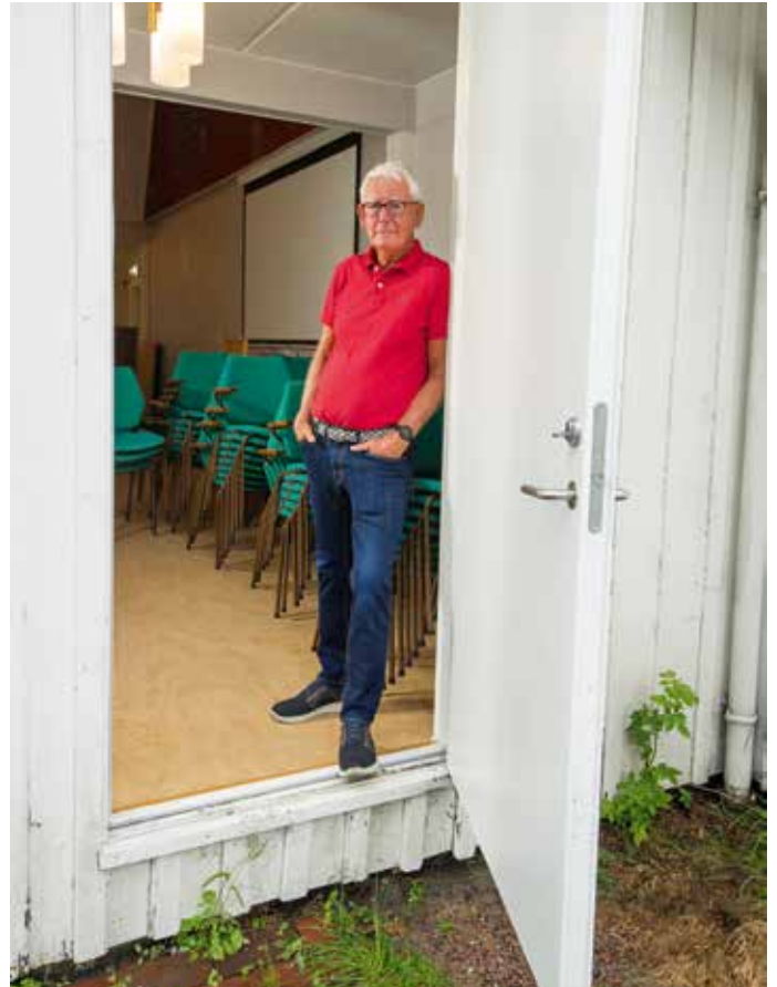
Vil senke terskelen: Roald Sexe konstaterer at en av rømningsveiene mangler trapp. Dugnadsgjengen er satt på saken.
